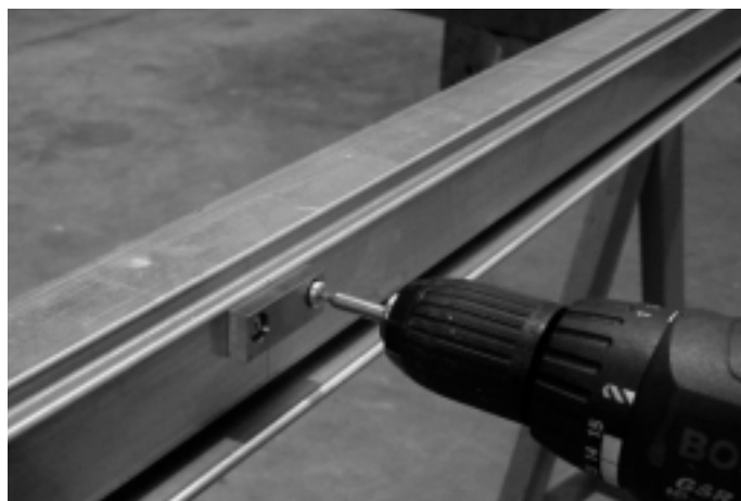
Abb. 29 Befestigung Falzsicherungsklötze mit Linsenschrauben 550.375
