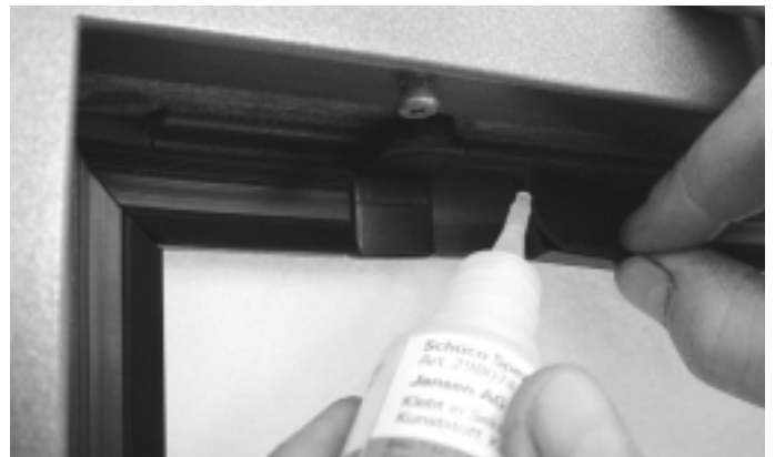
Abb. 21 Verkleben mit Belüftungswinkel Fig. 21 Coller avec l'équerre d'aération
