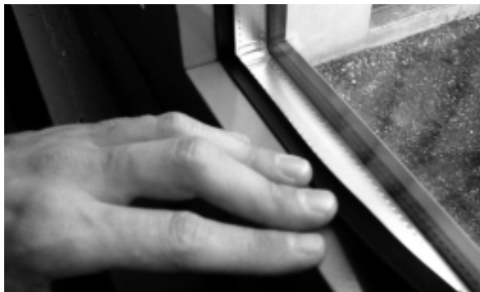
Abb. 31 Einbau der Innendichtung Fig. 31 Montage du joint intérieur
