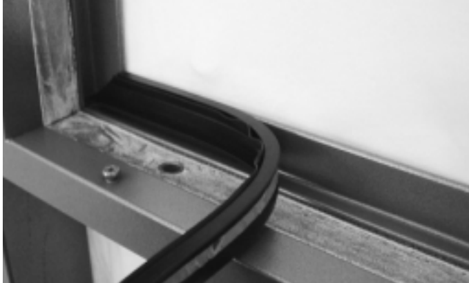
Abb. 19a Aussendichtung montieren Fig. 19a Monter le joint extérieur
