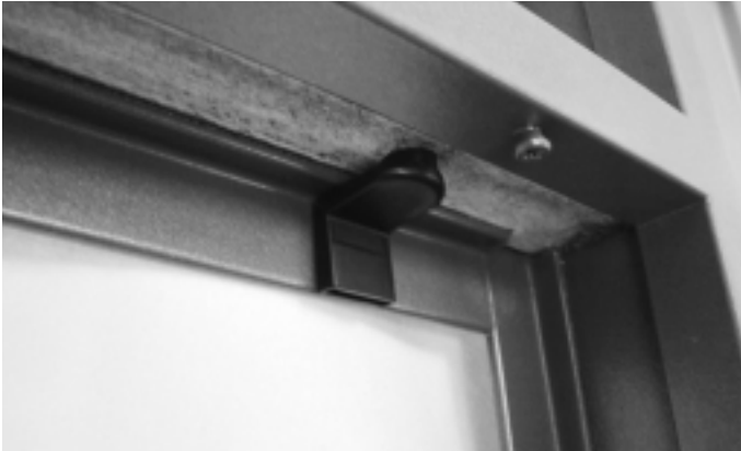
Abb. 11 Belüftungswinkel aufstecken Fig. 11 Monter équerre de ventilation
