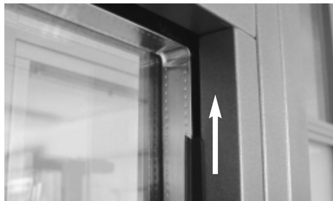
Abb. 30 Eindrücken der Dichtung Fig. 30 Enfoncement du joint
