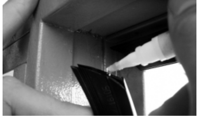
Abb. 19b Gehrungsecken verkleben Fig. 19b Coller les angles d'onglet
