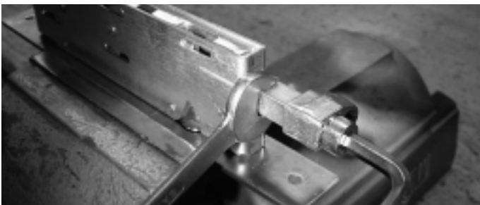
Abb. 33 Montage der Anschlussgarnitur 555.225 Fig. 33 Montage de la garniture de raccordement 555.225
