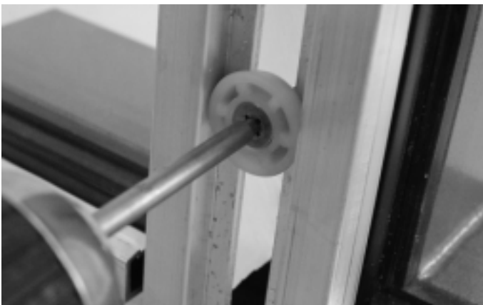
Abb. 29 Spezialschraube M5 mit Zentrierscheibe mittels Akku-Bohrschrauber anziehen
