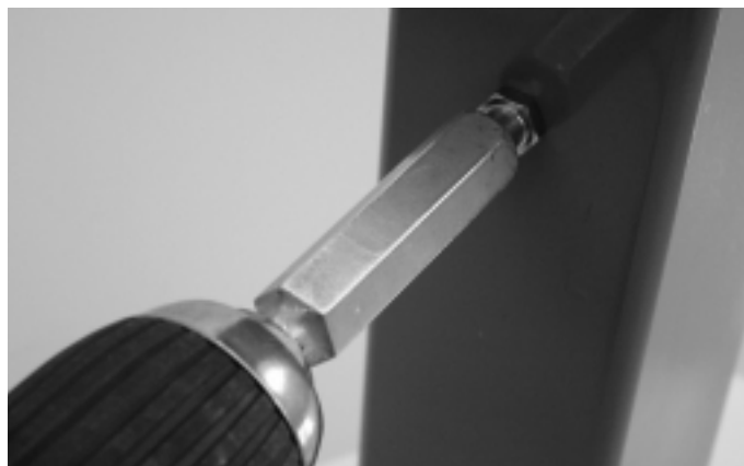
Abb. 26 Anziehen der Schraubbolzen resp. Schraub-Traganker mit Akku-Bohrschrauber (Drehmoment ca. 4-5 Nm) Ill. 26 Serrage des goujons à visser resp. des boulons- supports à visser avec visseuse à accumulateur (couple env. 4-5 Nm)
