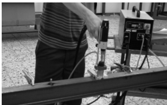
Abb. 7 Bolzen-Schweißgerät im Einsatz Ill. 7 Appareil à souder les goujons en action
