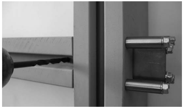
Bohren des Gewindelochs \varnothing 4,2 in Riegel-Befestigungsteil Perçage \varnothing 4,2 dans l'élément de fixation Drill the screw hole \varnothing 4.2 in the transom fixing component
