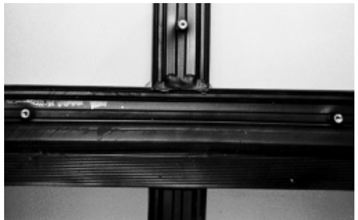
Abb. 7 Stoss mit Kleber ausstreichen Ill. 7 Point de raccord enduit de colle
