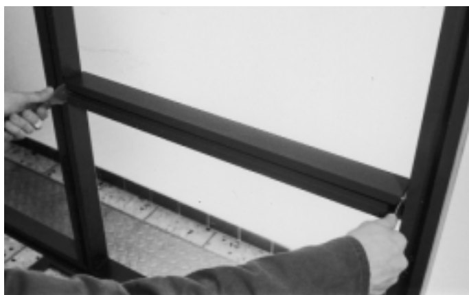
Abb. 31 Kurze Riegel einhängen (Ein-Mann-Montage) Ill. 31 Insertion d'une traverse courte (montage à une pers.)
