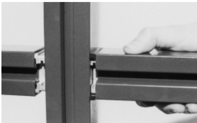
Abb. 33 Dichtmanschette einsetzen und mittels Riegelprofil andrücken Ill. 33 Poser la manchette et appuyer au moyen du profilé de traverse
