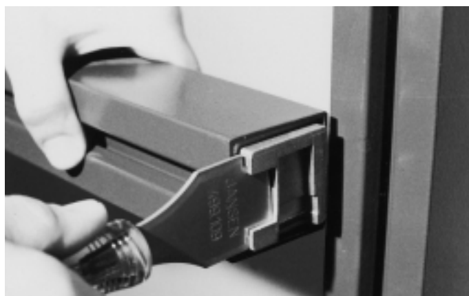
Abb. 30 ... und im Riegelprofil einschieben Ill. 30 ... et les introduire dans le profilé de traverse
